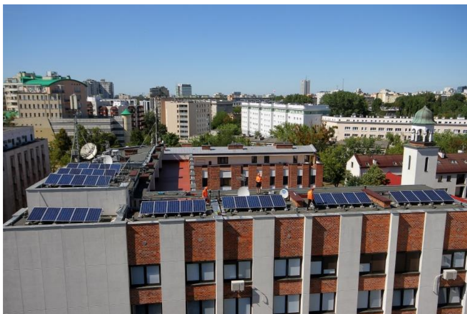
Instalacja fotowoltaiczna Columbus Energy S.A. w Głównej siedzibie Kolegium Episkopatu Polski
